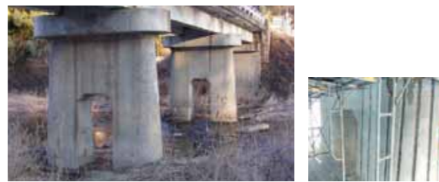
①着工前 ②埋設溝切削
