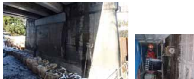
①着工前 ②埋設溝切削
