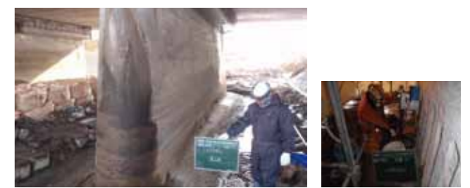
①着工前 ②コア削孔
