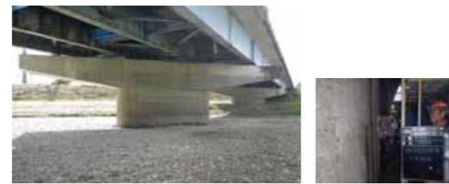
①着工前 ②埋設溝切削
