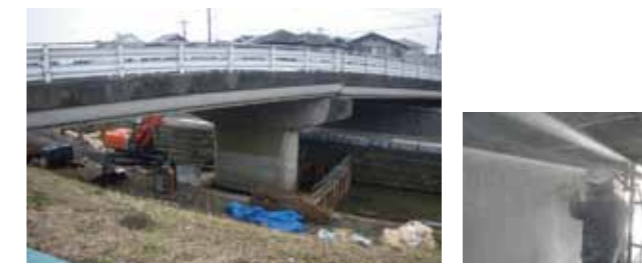
①着工前 ②埋設溝切削
