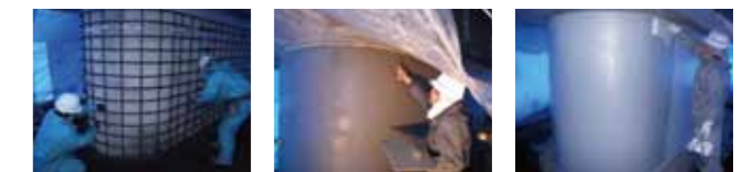
③主筋、帯筋 配筋取付 ④中塗材塗布 ⑤仕上材塗布
