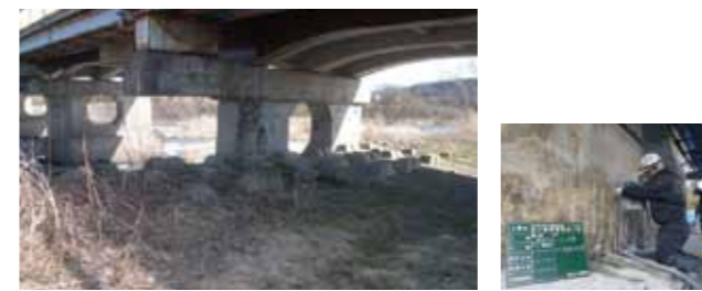
①着工前 ②コア削孔
