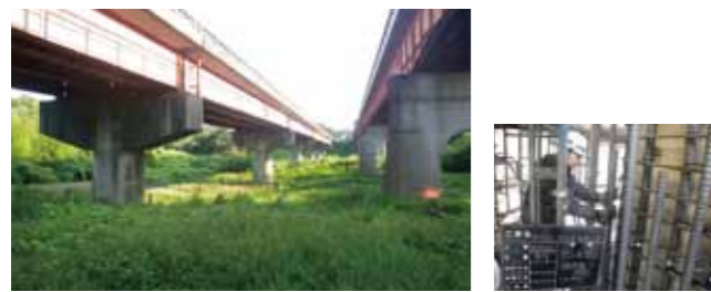
①着工前 ②主鉄筋取付
