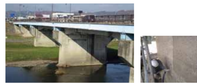
①着工前 ②下地処理(バキュームブラスト)
