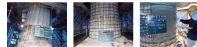
③埋設溝切削 ④帯筋取付 ⑤保護被覆中塗
