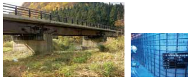
①着工前 ②下塗材吹き付け
