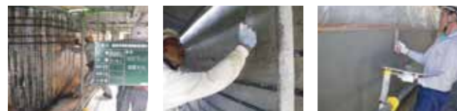
③帯鉄筋取付 ④保護被覆中塗 ⑤保護被覆定着材
