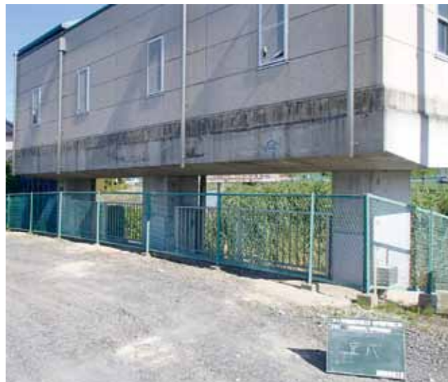
⑥完成 施工/秋田振興建設(株)
