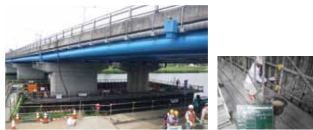
①着工前 ②主鉄筋取付
