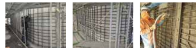
③主鉄筋取付 ④帯鉄筋取付 ⑤保護被覆中塗(吹付け工法)
