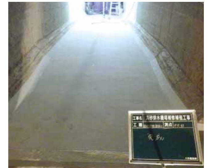
⑥完成 施工/(株)佐々木建設
