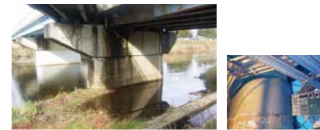
①着工前 ②断面修復
