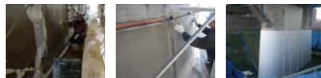
③保護被覆中塗(プライマー塗布) ④保護被覆ネット定着 ⑤保護被覆仕上材
