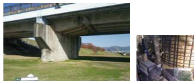
①着工前 ②保護被覆中塗(吹付け工法)
