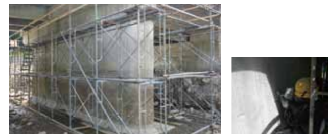
①着工前 ②埋設溝切削
