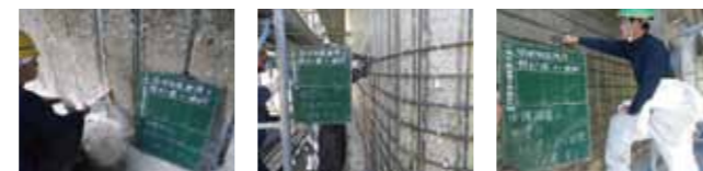
③埋設溝定着 ④帯鉄筋取付 ⑤保護被覆中塗
