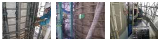
③帯鉄筋取付 ④保護被覆中塗 ⑤保護被覆定着材
