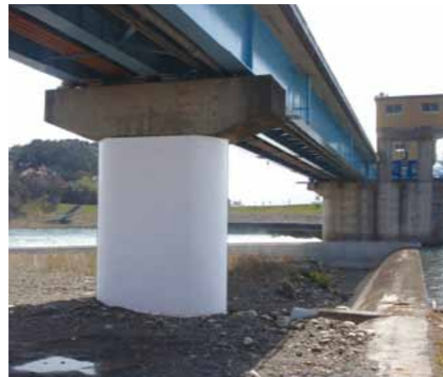
⑥完成 施工/(株)安部日鋼工業
