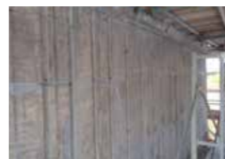
③主鉄筋埋設溝完了
