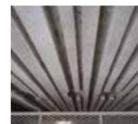
③埋設溝切削
