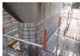
④帯鉄筋固定
