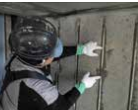
③ 主鉄筋埋設溝定着
