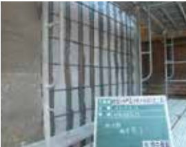
④ 帯鉄筋固定
