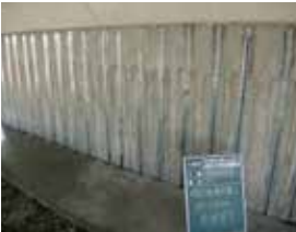
③ 主鉄筋埋設溝定着
