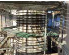
④ 帯鉄筋固定
