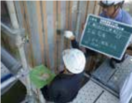
③ 主鉄筋埋設溝定着
