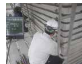
③ 帯鉄筋取付
