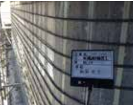
④ 帯鉄筋固定
