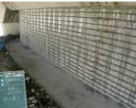
④ 帯鉄筋固定
