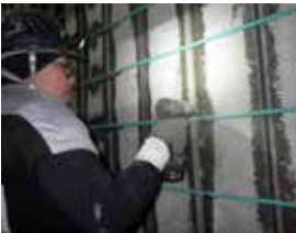
④ 帯鉄筋取付
