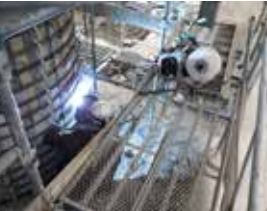
③ 帯鉄筋取付
