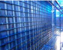
④ 帯鉄筋固定
