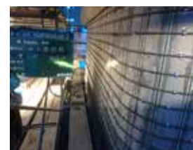
④帯鉄筋固定
