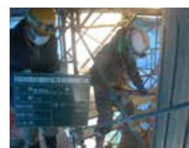
②主鉄筋埋設溝切削
