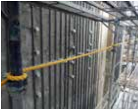
④ 主鉄筋固定
