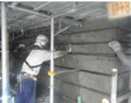
③ 帯鉄筋取付
