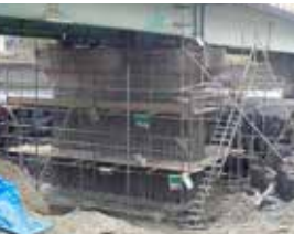
④ 帯鉄筋固定
