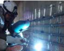
③ 帯鉄筋取付
