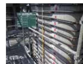
④ 帯鉄筋固定
