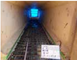
④ 帯鉄筋固定
