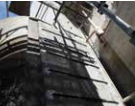
⑤ 帯鉄筋固定
