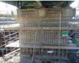
② 主鉄筋埋設溝切削
