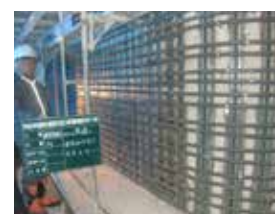
④帯鉄筋固定
