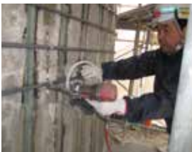
④ 帯鉄筋取付
