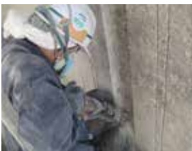
② 主鉄筋埋設溝切削
