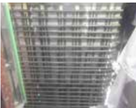
④ 帯鉄筋固定
