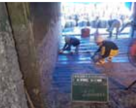
③ 主鉄筋埋設溝定着
