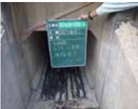
③ 主鉄筋埋設溝定着
