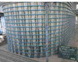
③ 帯鉄筋固定
