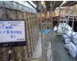
④ 帯鉄筋固定
