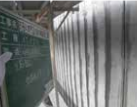
③ 主鉄筋埋設溝定着
