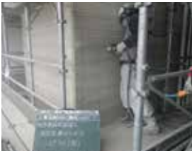
② 埋設溝切削
