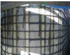
④ 帯鉄筋固定
