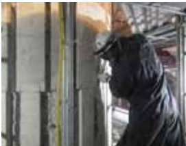
② 主鉄筋埋設溝切削
