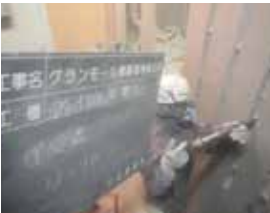
② 主鉄筋埋設溝切削
