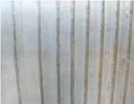
② 主鉄筋埋設溝切削
