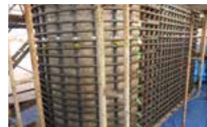
③帯鉄筋固定
