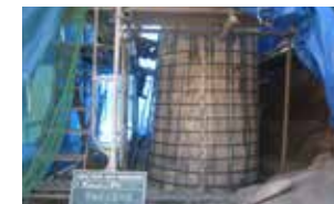
④帯鉄筋固定
