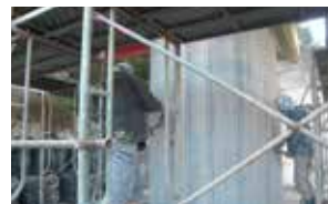
②主鉄筋埋設溝切削
