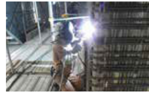
⑤フレア溶接
