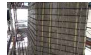
④帯鉄筋固定
