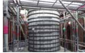
④帯鉄筋固定
