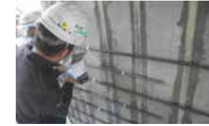
④帯鉄筋固定
