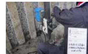
②埋設溝切削
