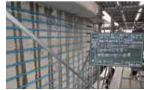
③帯鉄筋固定
