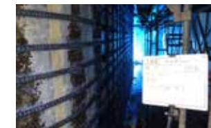
④帯鉄筋固定
