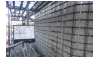
④帯鉄筋固定
