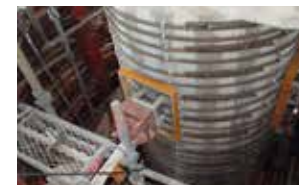
④帯鉄筋固定
