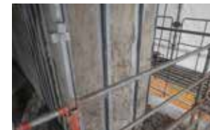
④主鉄筋埋設溝定着
