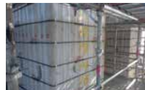
③帯鉄筋固定
