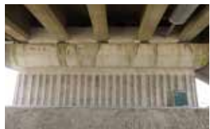
②主鉄筋埋設溝切削
