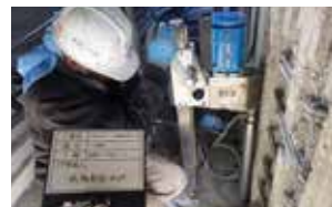
②主鉄筋埋設溝切削
