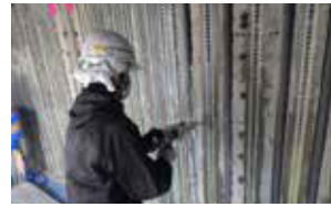
④主鉄筋埋設満定着
