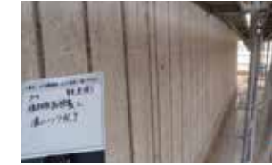
②主鉄筋埋設溝切削
