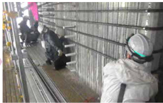
⑥帯鉄筋固定
