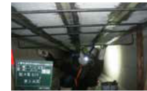
③配力鉄筋固定
