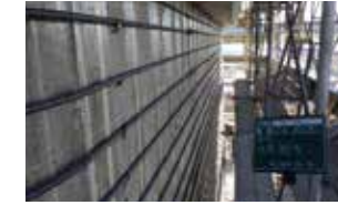
④帯鉄筋固定
