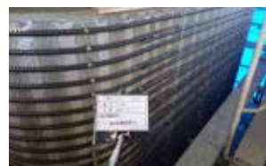
④帯鉄筋固定
