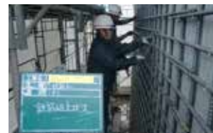
③帯鉄筋固定
