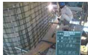
④帯鉄筋固定
