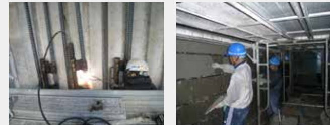
④ガス圧接
