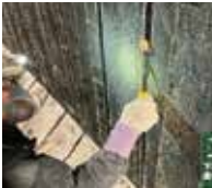
⑤ 保護被覆工(中塗り)
