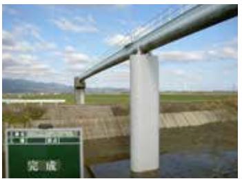
猪狩川水管橋
